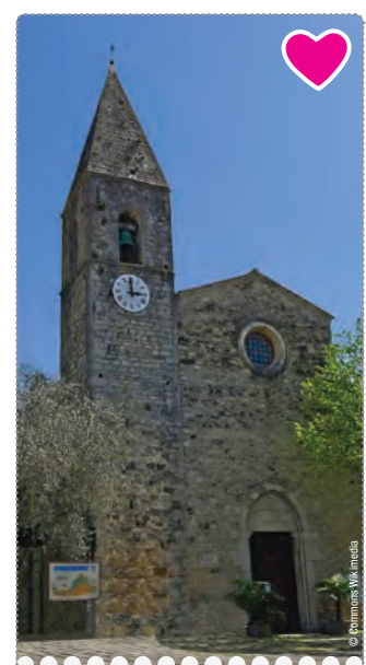
L'église Saint-Martin Saint-Martin's church
