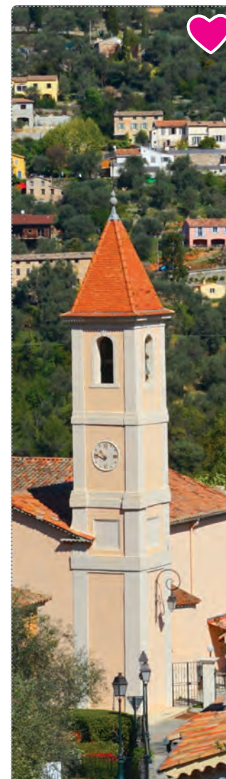
L'église paroissiale Parish church
