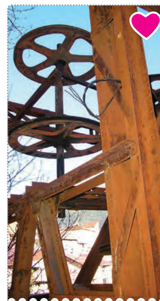
La machinerie du câble Cable machinery
